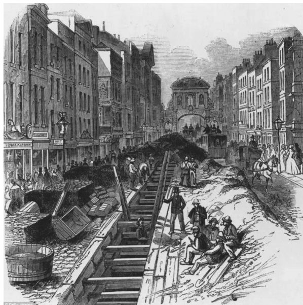
Κατασκευή υπονόμων στο Λονδίνο του 19 ου αιώνα.
